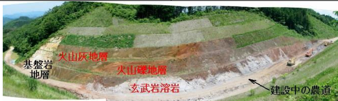
伊良尾火山の噴出物露頭(写真は山口農林事務所提供)
